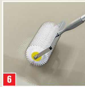
Die Entlüftung der Masse mit einer Stachelwalze unterstützen.
