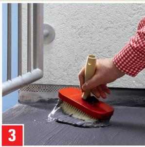
Erste Schicht UNIVERSAL-ABDICHTUNG gleichmäßig dick mit einem geeigneten Werkzeug (z. B. Pinsel, Fugbrett, Glätter) auftragen (Schichtdicke je Lage 1 mm – 1,25 mm). Einbauteile dabei deckend überarbeiten. Mindestens 2 Stunden trocknen lassen.
