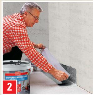
UNIVERSAL-ABDICHTUNG am einzudichtenden Bereich auftragen, Systemeinbauteil (z. B. DICHTUNGS-BAND) direkt einlegen und sofort ausrichten. Mit geeignetem Werkzeug leicht andrücken und blasen- und faltenfrei einbetten. Stoßbereiche sollen mind. 5 cm überlap-pen. Beachten Sie die Verarbei-tungshinweise der Systembauteile.
