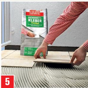
Fliesen mit zugelassenem Kleb-stoff kleben, z. B. SICHERHEITSKLEBER FLEXIBEL, SICHERHEITSKLEBER FLEXIBEL PLUS oder GROSSFORMAT-KLEBER Wand & Boden.
