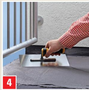
Nach dem Trocknen die zweite Schicht auftragen (Anmischver-hältnis siehe Punkt 1.) Vor dem Fliesenkleben die 2. Schicht 2 Stunden trocknen lassen. Dabei vor Nässe schützen.
