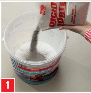
3,2 kg Flex-Zusatz in Anmischgefäß (z. B. Verpackungseimer) geben. Kanister mit max. 50 ml Wasser ausspülen und ebenfalls in das Anmischgefäß geben. 3,8 kg Dichtmörtel mit elektrischem Rührwerk (Korb- oder Doppel-flügelrührer) homogen und klumpenfrei einrühren.
