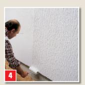
Die Struktur stellt sich durch das Durchrollen sofort ein. Variante der Rollstruktur: Grate können im frischen Zustand mit Glättkelle gebrochen werden.
