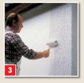
Den frischen Putz innerhalb 10-20 Minuten mit Strukturrolle durchrollen. Andere Strukturen können mit Fellrolle, Pinsel, Bürste, Schwamm erzielt werden.
