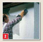
Putz mit Rührwerk durchrühren. ROLLPUTZ mit Glättkelle dünnlagig (1-2 mm) aufziehen. Rostfreies Werkzeug verwenden.
