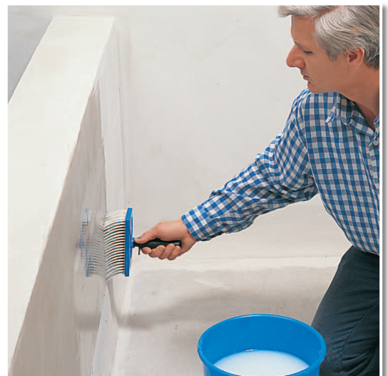
Grundierung in einer Ölauffangwanne vor der Beschichtung mit NEUER ANSTRICH.
