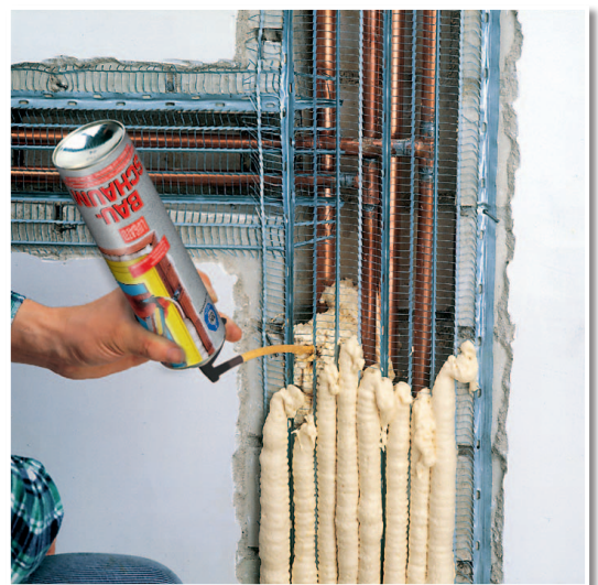
Dämmung von Heizrohren gegen Wärmeverluste.
