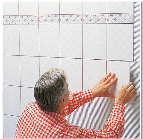
Fliesen im Bad wasserdicht kleben.
