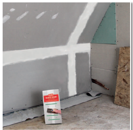
Dachausbau mit Gipskartonplatten: Fugen mit GLATTE SACHE FUGENSPACHTEL gefüllt.
