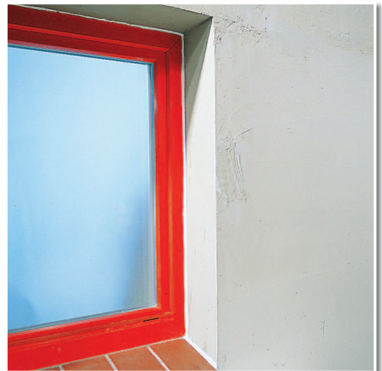
Verschluss der Anschlussfugen zwischen Fenster und Mauerwerk.
