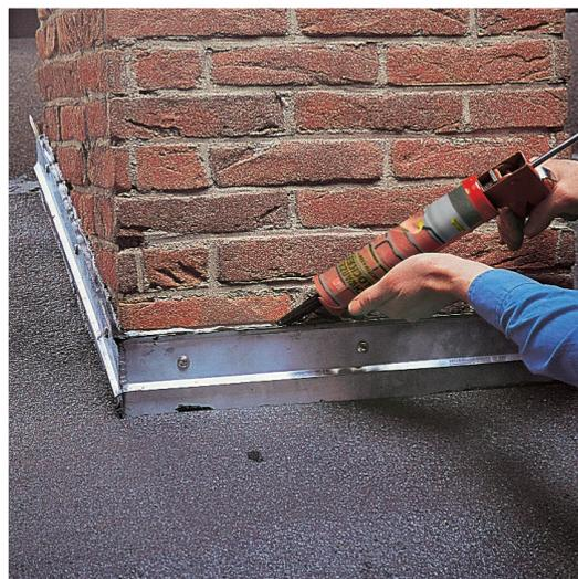
Étanchéification d'une barre de contrefort sur une cheminée avec le SCHWARZER BLOCKER DICHTMASSE.
