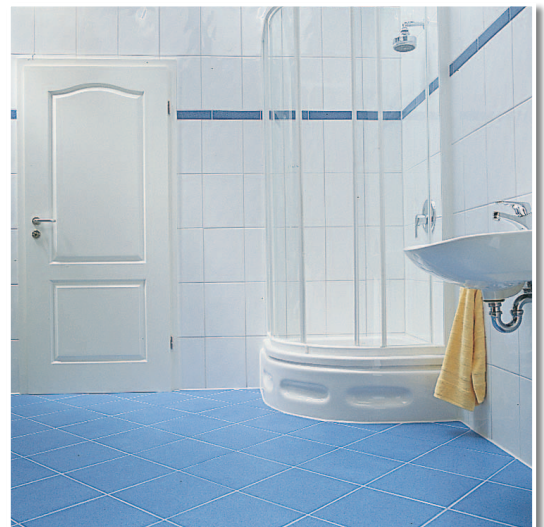
Die fertige Dusche. Eck- und Anschlussfugen elastisch abgedichtet.
