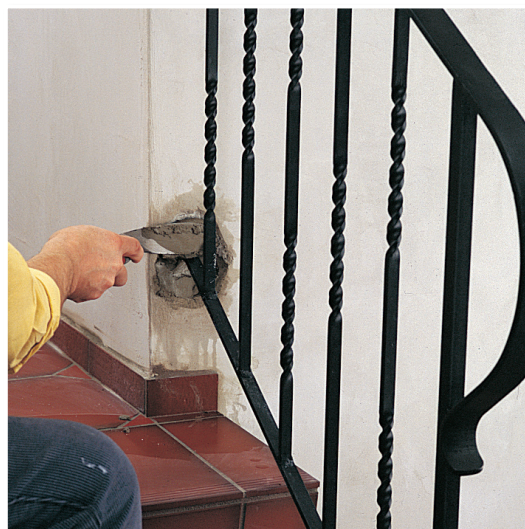
Typische Anwendung: Montage eines Treppengeländers.
