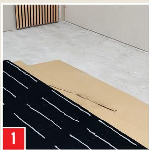
AKUSTIK-PANEEL-KLEBER in senkrechten, mind. 5 mm breiten Streifen und in gleichmäßigen Abstand auf die Rückseite der Paneele auftragen.
