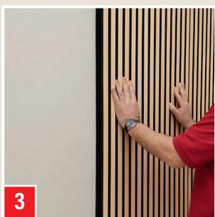
Paneele ausrichten und fest andrücken. Bei größeren schwereren Paneelen ist eine zusätzliche mechanische Fixierung nötig.
