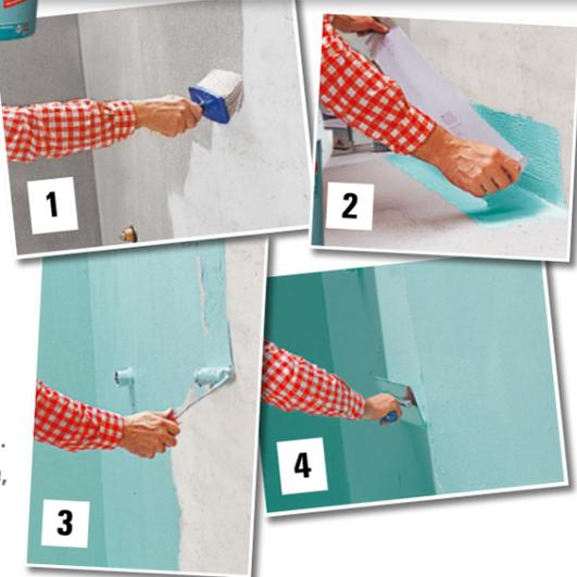
Erforderliche eingebaute LUGATO Systembauteile deckend überstreichen. Erste Schicht mind. 5 Stunden trocknen lassen. Der Auftrag kann mit Rolle, Glätter oder Moosgummi-brett erfolgen.
