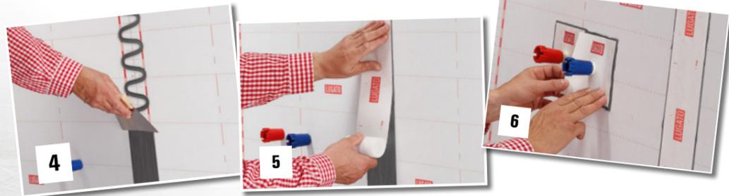
4 BOMBENFEST ausspritzen und mittels Zahnspachtel mittig über dem Stoßbereich 12 cm breit auftragen.
