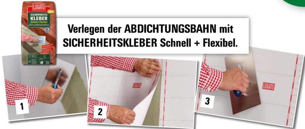
1 Klebstoff mit Zahnkelle (Blockzahnung 4 mm) bahnenweise auf Untergrund auftragen.
