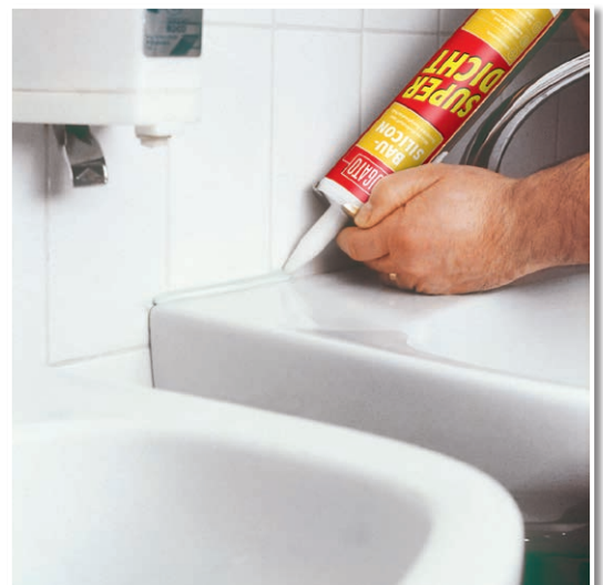
Fuge am Waschbecken dauerelastisch abdichten.
