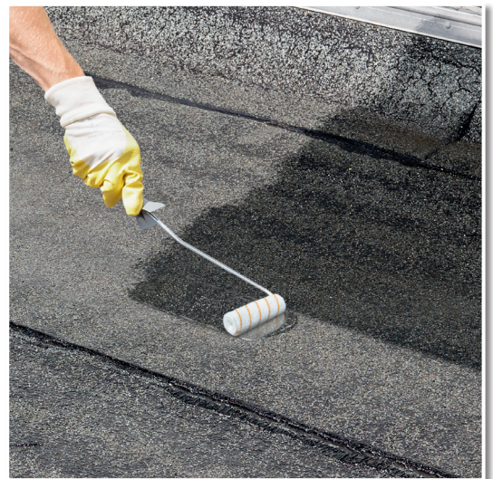
HAFTGRUNDIERUNG mit Fellrolle oder Pinsel auf den Untergrund auftragen.
