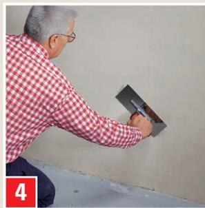
**4** Pour obtenir une surface lisse, aplanir une nouvelle fois au lissoir en acier (non nécessaire avant la pose de carrelage). Nettoyer les outils à l'eau.
