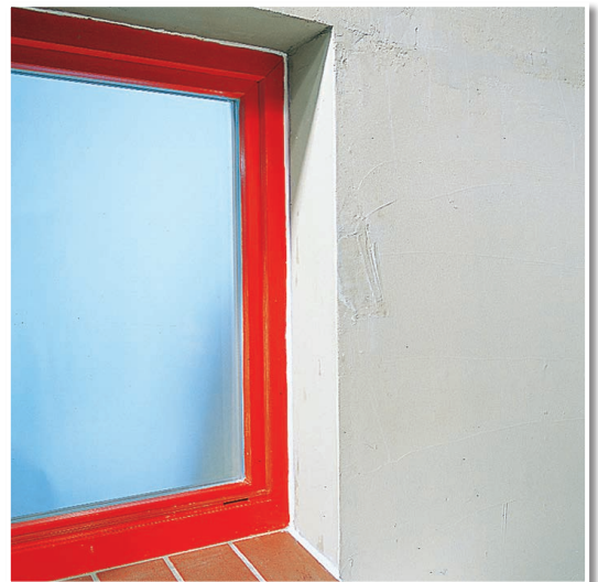
Verschluss der Anschlussfugen zwischen Fenster und Mauerwerk.
