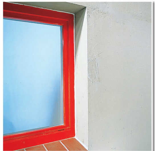
Verschluss der Anschlussfugen zwischen Fenster und Mauerwerk.
