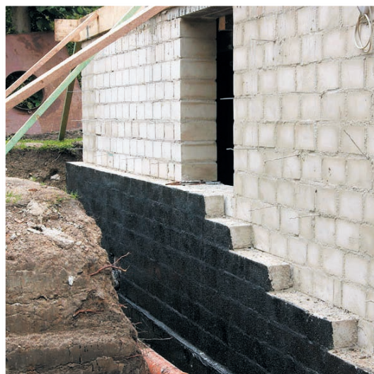
Étanchéité élastique et sans jonction d'un mur de cave extérieur avec le film de protection SCHWARZER BLOCKER SCHUTZFOLIE.)
