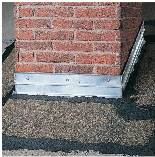
Barre de contrefort sur une cheminée étanchéifiée avec du mastic SCHWARZER BLOCKER SPACHELMASSE et une bande de bitume.
