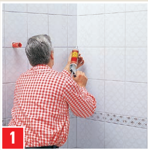
1 Eckfuge mit SUPER DICHT elastisch abdichten.
