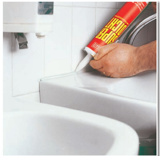
Fuge am Waschbecken dauerelastisch abdichten.
