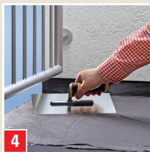
Dopo l'asciugatura applicare il secondo strato (per il rapporto di miscelazione vedere punto 1). Prima di incollare le piastrelle lasciar asciugare il secondo strato almeno 2 ore. Durante questa operazione proteggere dall'acqua.
