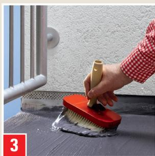
Applicare il primo strato di UNIVERSAL-ABDICHTUNG con uno spessore uniforme usando un attrezzo adatto (come un pennello, una tavola per fughe, un attrezzo rasante) (spessore per ogni strato 1 mm – 1,25 mm). Coprire completamente gli elementi. Lasciar asciugare almeno 2 ore.
