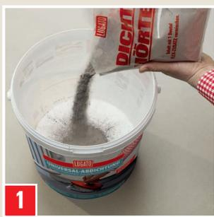
Aggiungere l'additivo Flex da 3,2 kg nel recipiente di miscelazione (ad esempio il contenitore della confezione). Mescolare 3,8 kg di malta sigillante con agitatore elettrico a bassa velocità fino ad ottenere un prodotto omogeneo e privo di grumi.
