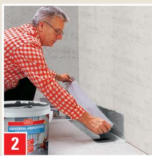
Spalmare UNIVERSAL-ABDICHTUNG sull'area da sigillare, appoggiare direttamente un componente di sistema (ad esempio il nastro impermeabilizzante DICHTUNGSBAND) e allineare subito. Premere leggermente con un attrezzo adatto e introdurre senza bolle e senza pieghe. Nelle zone delle giunzioni sovrapporre almeno 5 cm. Rispettare le istruzioni di lavorazione dei componenti di sistema.
