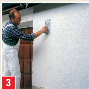
3 Innerhalb 10–20 Minuten mit Kunststoffglätter strukturieren. Waagrecht, senkrecht, kreisförmig oder diagonal.
