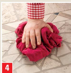
Le dernier voile peut être éliminé en frottant au bout de quelques heures avec un chiffon doux, ou le jour suivant à l'aide d'une éponge humide. Les joints de jonction et de dilatation peuvent être obturés au bout de 2 jours environ avec WIE GUMMI BAD-SILICON, par exemple.
