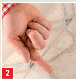
Laisser le mortier prendre. Le bon moment est atteint lorsque le mortier ne colle plus au bout des doigts (dépend des conditions sur le chantier, de la largeur des joints, du type de carrelage). Ensuite, niveler la surface des joints à l'aide d'une éponge légèrement humide. Laisser une nouvelle fois le mortier prendre.
