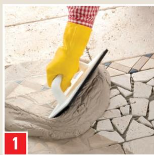
Répartir le mortier p. ex. à l'aide d'une taloche en caoutchouc mousse et introduire généreusement la matière dans les joints par des mouvements en diagonale par rapport au sens du joint. Ensuite, étaler le mortier en excès sur la surface du carrelage.
