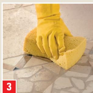
Nettoyer les carreaux à l'aide d'une éponge ou d'un lisseur à éponge. Ce faisant, tirer l'éponge uniquement dans une direction et en exerçant une légère pression. Rincer fréquemment l'éponge et bien l'essorer. Le cas échéant, répéter l'opération.
