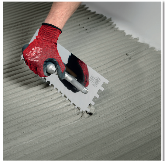
Gleichmäßiger Auftrag von Fliesenkleber.
