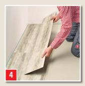
Bodenbelag nach einer Ablüftezeit von 10-30 Min. vollflächig einlegen.
