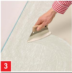
**3** Vor Gebrauch gut aufrühren. DESIGN- & PVC-BELAGSKLEBSTOFF mit geeigneter Zahnung gleichmäßig auf dem Untergrund verteilen. Klebstoffnester vermeiden.
