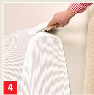
**4** ...und mit der passenden Spachtelzahnung gleichmäßig auf dem Untergrund verteilen. Klebstoffnester vermeiden.
