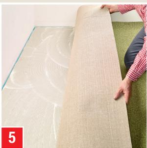
**5** Den zurückgeschlagenen Teppich in das Klebstoffbett einlegen und mit einem geeigneten Werkzeug gut anreiben, besonders am Rand- und Nahtbereich. Diesen Vorgang nun auch mit der anderen Hälfte wiederholen.
