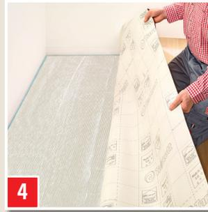
**4** Den zurückgeschlagenen Belag nach der Ablüfzeit einlegen und mit einem passenden Werkzeug gut anreiben. Diesen Vorgang nun auch mit der anderen Hälfte wiederholen.
