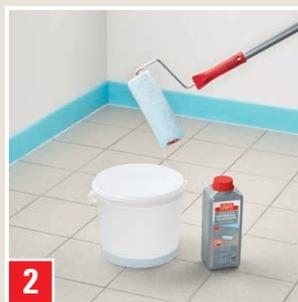
Appliquer au rouleau UNIVERSAL-GRUNDIERUNG sur le support et en fonction du pouvoir absorbant du support, laisser sécher pendant 1 à 4 heures.
