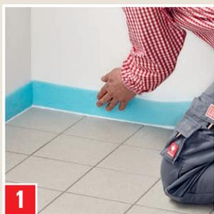
Entre le mur et le sol, placer tout autour une bande d'isolation des bords. Étanchéifier avec RISS-UND FUGEN-ZU.
