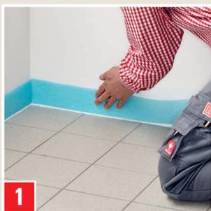
Umlaufend zwischen Wand und Boden einen Randdämmstreifen setzen. Mit RISS-UND FUGENZU unterlaufsicher abdichten.
