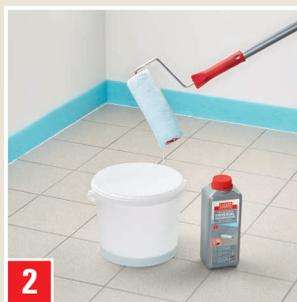
UNIVERSAL-GRUNDIERUNG auf den Untergrund mit einer Rolle auftragen und je nach Saugfähigkeit des Untergrundes 1 bis 4 Stunden trocknen lassen.
