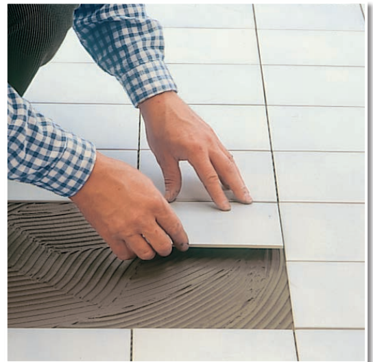
Fliesenkleben auf einem Heizstrich.
