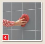
Letzte Schleier können nach einigen Stunden mit einem weichen Tuch nachpoliert oder am nächsten Tag mit einem angefeuchtetem Schwamm entfernt werden.
