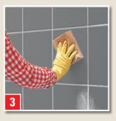
Mörtel in der Fuge ansteifen lassen. Dann die Fugenoberfläche mit leicht angefeuchtetem Schwamm einebnen ("bügeln"). Mörtel erneut ansteifen lassen. Anschließend Fliesenoberfläche mit feuchtem Schwamm oder Schwammbrett reinigen.
