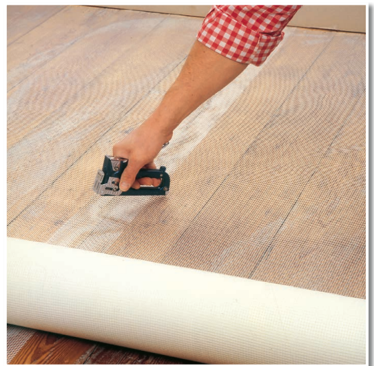
Die Armierung vor dem Ausgleichen mit NEU AUF ALT!.
