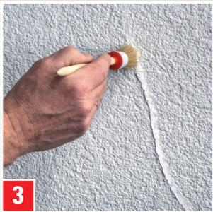
**3** Je nach Struktur des Dekorputzes, frische Dichtmasse mit angefeuchtetem Pinsel oder Spachtel der Putzoberfläche anpassen.
