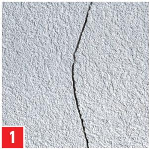
**1** Rissverschluss in einem Dekorputz: Riss auf 5 mm aufweiten.
