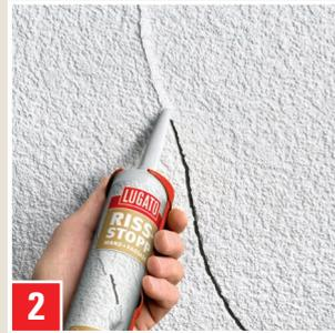
**2** RISS-STOPP mit Auspresspistole in den Riss satt einspritzen.
