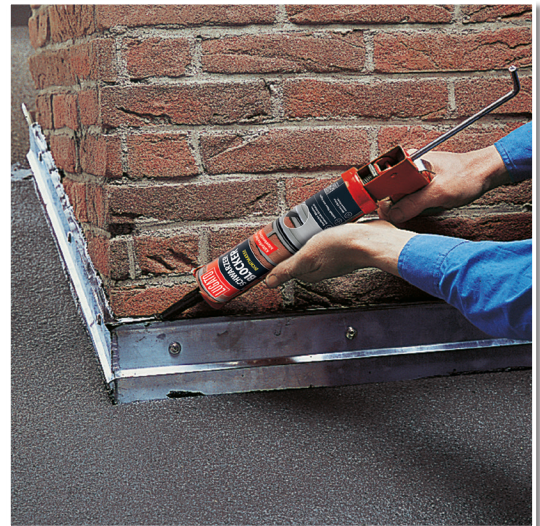
Abdichten einer Kappleiste am Schornstein mit SCHWARZER BLOCKER DICHTMASSE.
