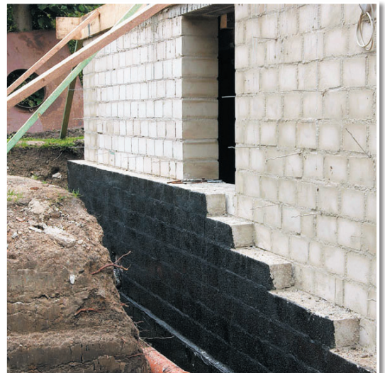
Nahtlose und flexible Abdichtung einer Kelleraußenwand mit SCHWARZER BLOCKER SCHUTZFOLIE.
