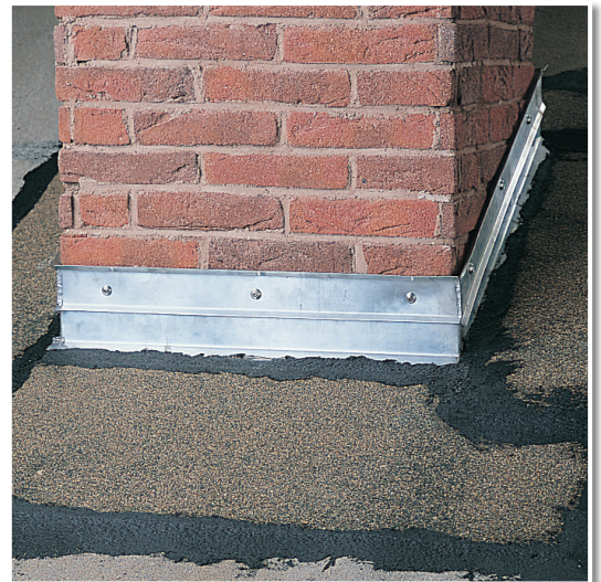
Kappteile am Schornstein mit SCHWARZER BLOCKER SPACHTELMASSE und Bitumenbahn abgedichtet.
