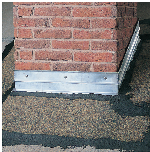
Kappteile am Schornstein mit SCHWARZER BLOCKER SPACHTELMASSE und Bitumenbahn abgedichtet.
