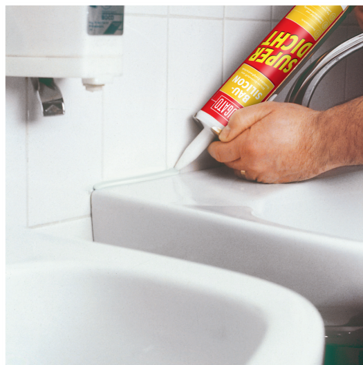
Fuge am Waschbecken dauerelastisch abdichten.
