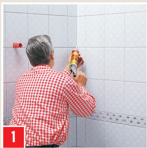
1 Eckfuge mit BAU-SILICON SUPER DICHT elastisch abdichten.
