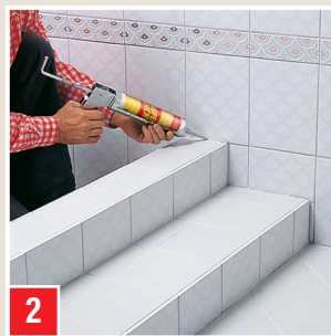
2 Anschlussfuge mit BAU-SILICON SUPER DICHT elastisch abdichten.
