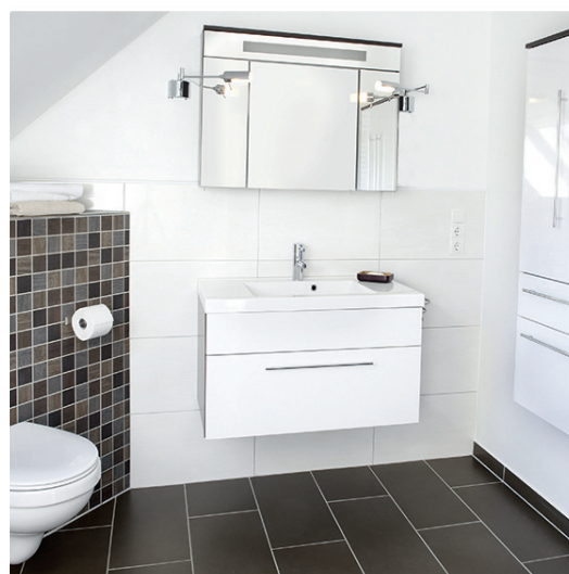
La salle de bains terminée. Avec des joints en SICHERHEITSFUGE FLEXIBEL.
