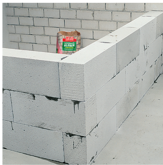
Mit SICHERHEITSKLEBER PORENBETON geklebte Wände.
