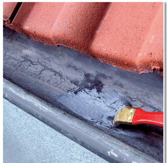
Reparatur einer Regenrinne mit SOFORT DICHT!.
