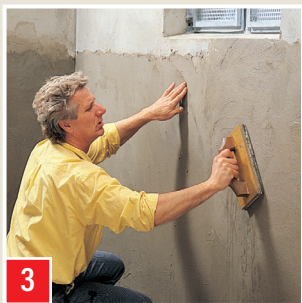
3 Nach etwa 30 Minuten mit Schwammbrett planebene Oberfläche herstellen.
