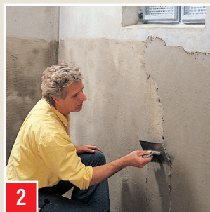
2 Zweite Schicht innerhalb 1-2 Stunden mit Stahlglätter aufziehen. Gesamtschichtdicke für beide Schichten: mind. 2 mm. Bei Anwendung 5: Gesamtschichtdicke 5 mm.
