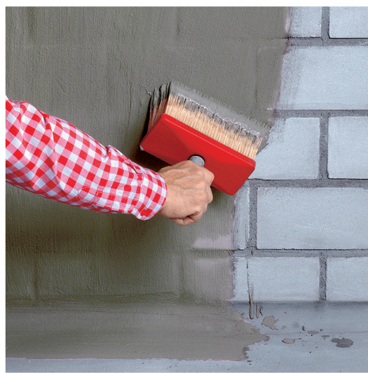
Abdichten mit TROCK'NER KELLER DICHUNGSSCHLÄMME, hier auf Kalksandsteinmauerwerk.
