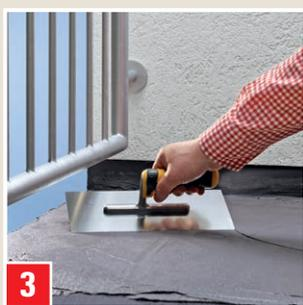
Après séchage, appliquer à la truelle lisse la deuxième couche constituée de 3 kg d'additif Flex et de 6 kg de mortier d'étanchéité au plus tôt 2 heures après. Appliquer la troisième couche au plus tôt 4 heures après. Laisser sécher pendant 24 jours. Protéger de la pluie et des rayons directs du soleil.
