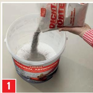
Mélanger : Verser 3 kg d'additif Flex dans le récipient de mélange (p. ex. le seau de l'emballage), incorporer lentement 6 kg de mortier d'étanchéité avec un agitateur électrique sur vitesse lente. Rincer le bidon avec max. 50 ml d'eau et verser également dans le récipient de mélange.
