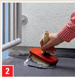
Appliquer la première couche à la brosse ou à la truelle lisse. Chaque couche doit être appliquée en épaisseur régulière et recouvrir intégralement la surface. Pour l'étanchéification des transitions entre murs et sols et dans les angles, se référer aux remarques générales (voir plus bas).
