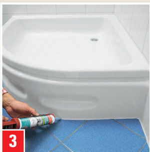
Abdichtung der Anschlussfuge zwischen Duschwanne und Bodenfliese.
