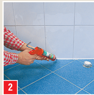
2 Herstellen der dauerelastischen Bodenfuge vor dem Setzen der Duschwanne.
