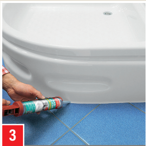
3 Abdichtung der Anschlussfuge zwischen Duschwanne und Bodenfliese.
