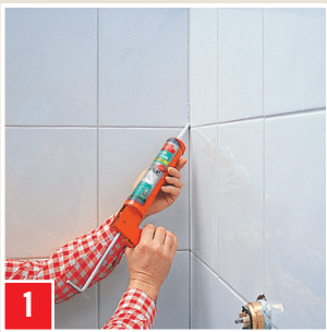
1 Dauerelastische Verschluss der Eckfuge.
