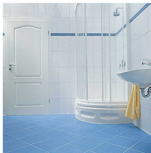
Die fertige Dusche. Eck- und Anschlussfugen elastisch geschlossen.
