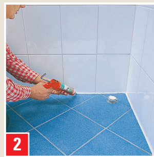
Herstellen der dauerelastischen Bodenfuge vor dem Setzen der Duschwanne.
