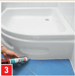
Abdichtung der Anschlussfuge zwischen Duschwanne und Bodenfliese.
