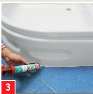
3 Abdichtung der Anschlussfuge zwischen Duschwanne und Bodenfliese.
