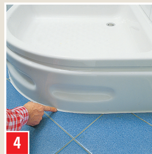
4 Dichtstoff innerhalb 10 Min. mit FUGENGLÄTTER (angefeuchtet mit SILICONGLÄTTMITTEL) abziehen.
