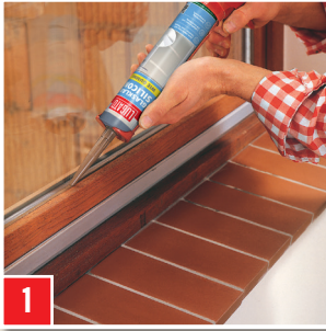
1 Fensterfalzversiegelung zwischen Glas und Holzrahmen.
