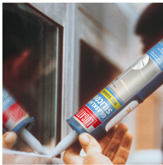
Fensterfalzversiegelung zwischen Glas und Alurahmen.
