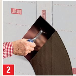
**2** Beispachteln der Nahtstelle der ABDICHTUNGSBAHN zur Vorbereitung für das Belegen mit Design- oder Vinylbelägen.
